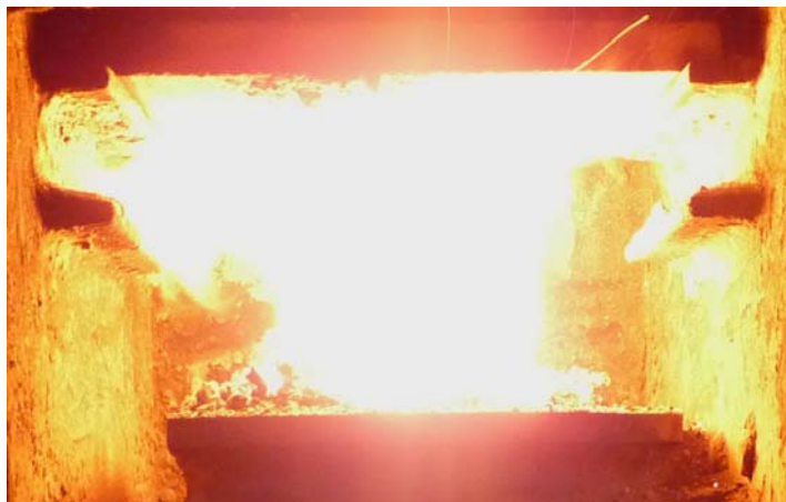
Obrázek 16. Práce retortového hořáku během vytápění uhlím Ling 15 – 50kW.
